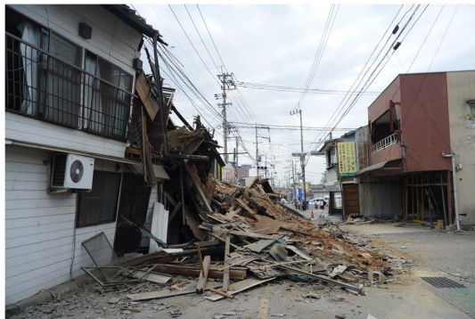
益城町の被災状況（4月16日筆者撮影）
