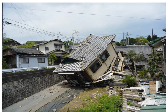
益城町の被災状況（4月16日筆者撮影）
