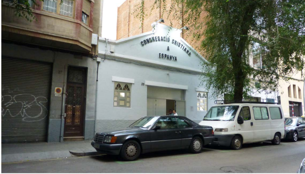
写真2 コングレガソン教会の外観（バルセロナ市）
