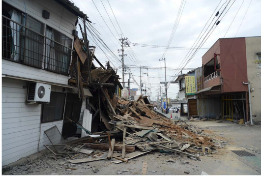
益城町の被災状況（4月16日筆者撮影）
