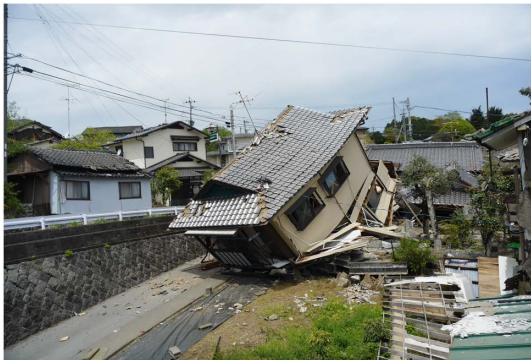
益城町の被災状況（4月16日筆者撮影）
